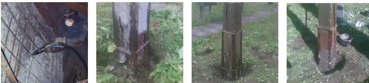
**Амокор КМ** - представляет собой двухкомпонентную низковязкую жидкость на органической основе. При нанесении на поверхность бетона, штукатурки и других пористых строительных материалов она диффундирует в их объем и отверждается там влагой воздуха, а также образует на поверхности прочную, химстойкую, водонепроницаемую пленку.
