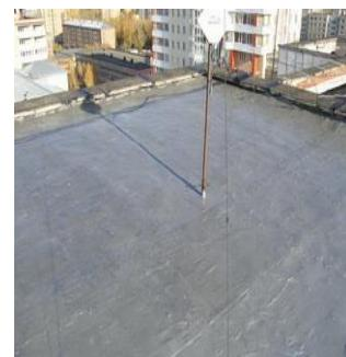
**Амокор КМ** - представляет собой двухкомпонентную низковязкую жидкость на органической основе. При нанесении на поверхность бетона, штукатурки, кирпича, дерева и других пористых строительных материалов она диффундирует в их объем и отверждается там влагой воздуха, а также образует на поверхности прочную, химстойкую, водонепроницаемую пленку.
